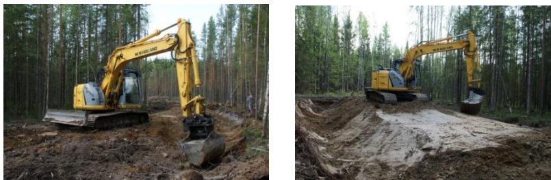
Рисунок 3 – Возведение земляного полотна способом «из канав» с профилировкой верха земляного полотна и боковых откосов
